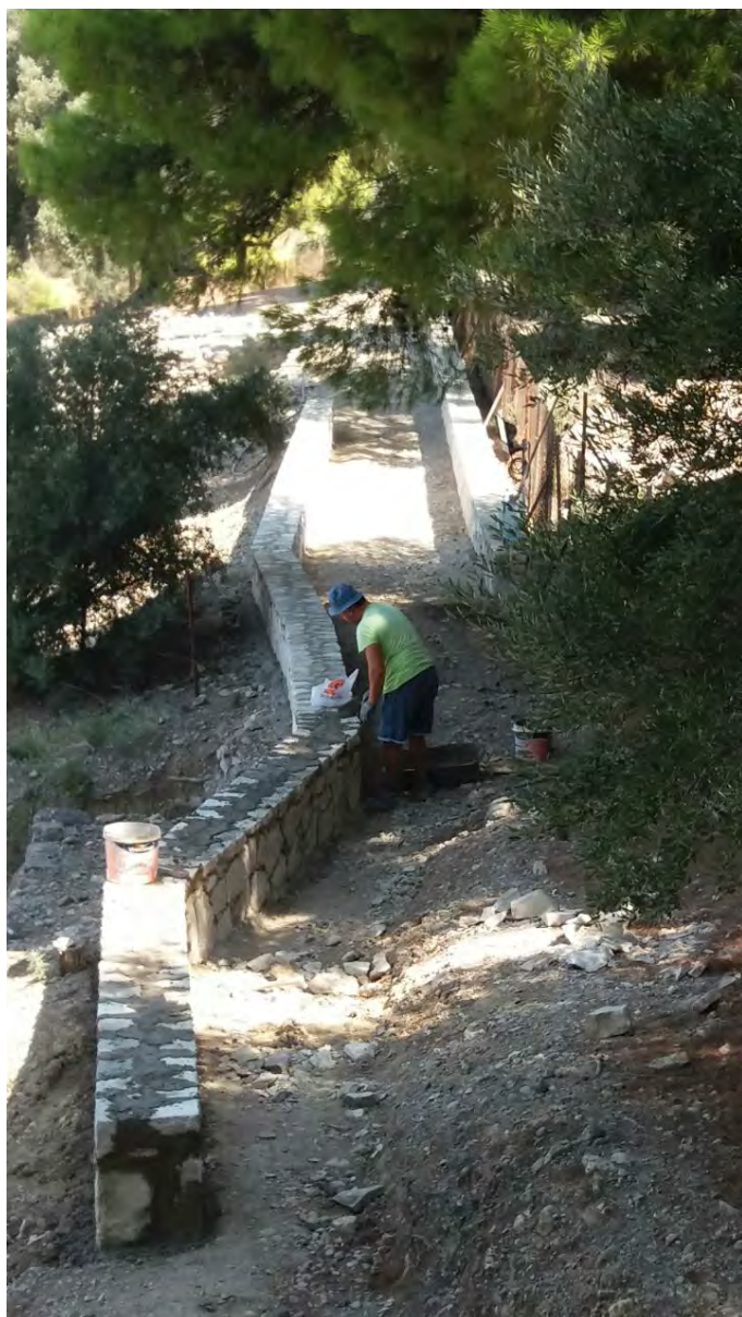
Tav. IX. Costruzione muro interno.
